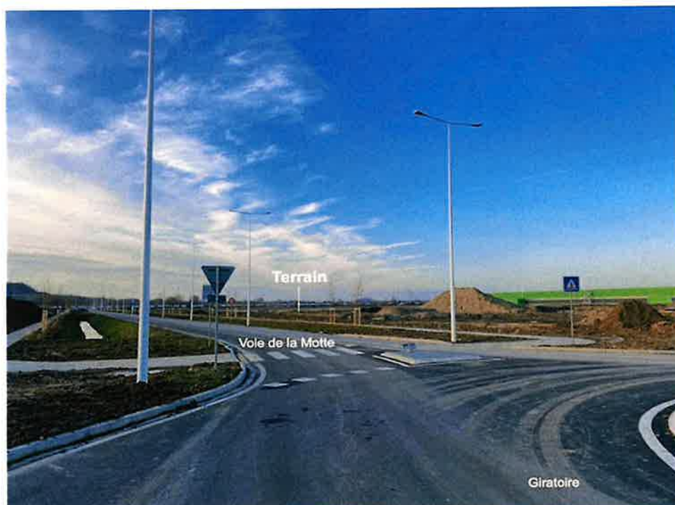
VUE DEPUIS LE GIRATOIRE DE LA VOIE DE LA MOTTE
